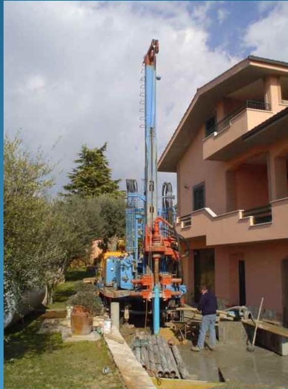
La realizzazione di pozzi e perforazioni geotermiche richiede un prodotto che sia in grado di sostenere sollecitazioni flessionali e torsionali elevate, unite a un design compatto e leggero.
